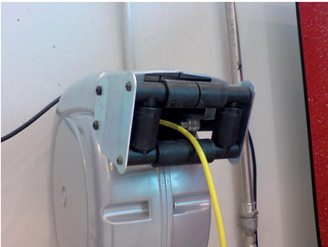
Tambour de câble à ressort en fonte d'aluminium type PRC pour liaison équipotentielle (obligatoire dans l'aviation):
